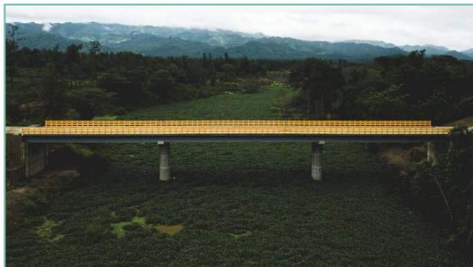
Puente sobre el Río Guayambre, Patuca, Olancho
