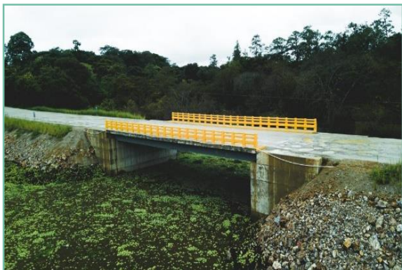
Puente sobre Terrero Prieto, Patuca, Olancho
