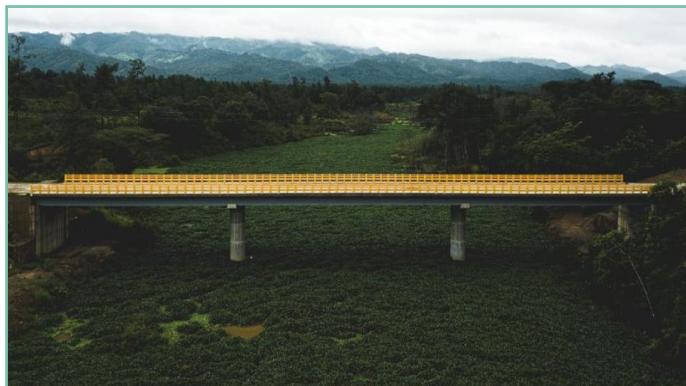
Puente sobre el Río Guayambre, Patuca, Olancho
